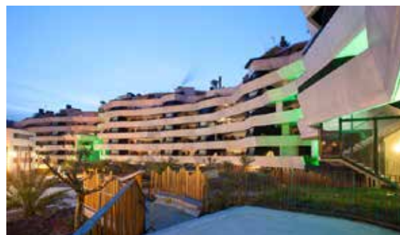
Residential Complex (roof gardens) Kompleks mieszkalny (zielone dachy)
